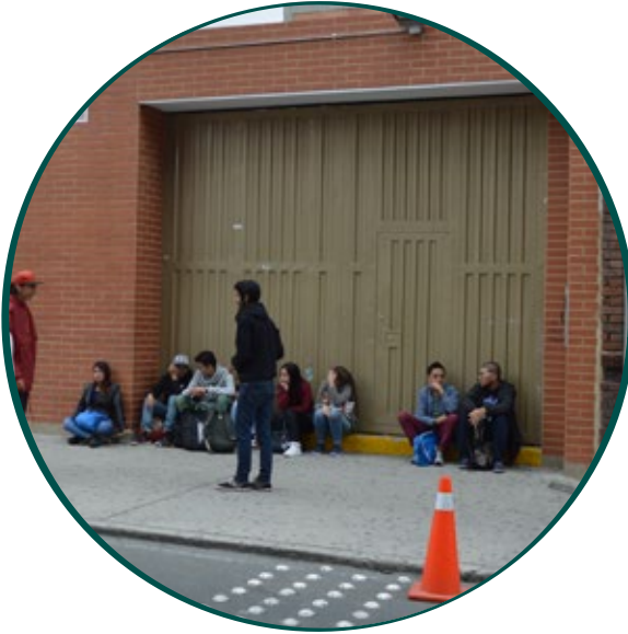
Edificio A Carrera 16 N° 63A-55
