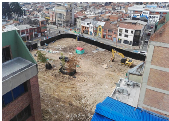
Demolición de predios
