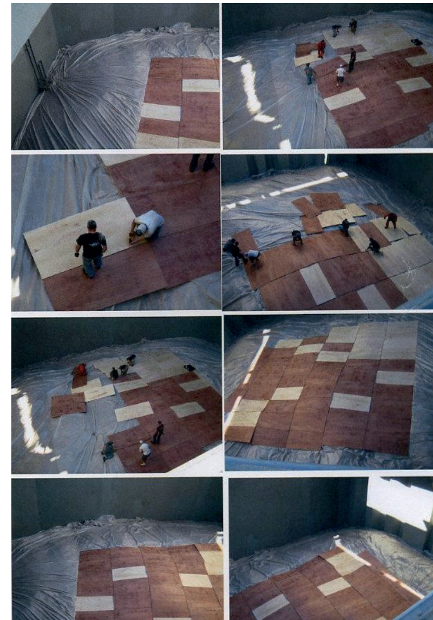
Figura 3. Material de Estiba de Madera (MEM) empleado para la división de cargas (trimado) en las bodegas de los buques mercantes. Fuente: el autor; OPP GRANELES S.A.
